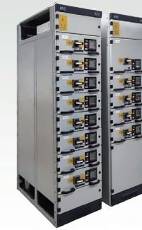
SDB低压成套开关设备 (低压抽出式开关柜)
